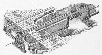
Abb. 67 und 68. A. S. Hallidies Strassenbahn mit umlaufendem Seil, erstmals in Betrieb gesetzt 1873 in San Franzisco ["S. B. Z." 20, Januar 1883].
