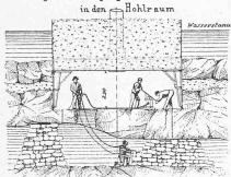
Abb. 41. Unterfahrung einer Caissonschneide durch Taucher. Brücke über die Dordogne. [Aus der "S. B. Z." vom 25. August 1883.]
