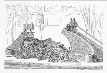
Abb. 32. Beton-Brückengewölbe an der Schweiz. Landesausstellung Zürich 1883. Bogen 6 m weit, Pfeil 2 m, Scheitelstärke 12 cm, Beton 1:5, Bruchlast 5,46 t/m². Versuchsbericht von Prof. L. Tetmajer, Dir. der E. M. P. A. in "S. B. Z." 17. Nov. 1883.
