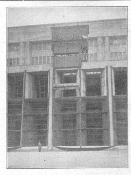
Energie Electrique du Rhin. Kraftwerk Kembs. Rechenreinigungsmaschine.
