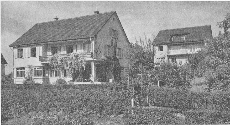
Abb. 6. Haus Stiefel (links vorn) und Haus Wegelin (rechts hinten), aus Südosten gesehen.
