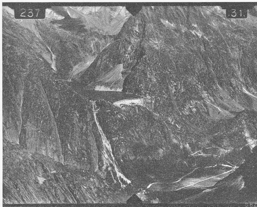
Abb. 33. Stausee Gelmer der K. W. O. und Umgebung, aus Westen, von Station links der 897,07 m langen Basis Aarlegletscher, 2617,8 m ü. M. — Aufnahmeaxe normal zur Basis und um 12 gr. abwärts gekippt. Phototheodolit Nr. 31, Brennweite 237 mm. (Cliché in Naturgrösse der Platte).
