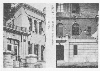
Abb. 5. Bebenwirkung beim Zusammenbau verschiedenartiger Bauteile.
