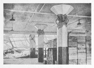
Abb. 1. Zerstörung eines Eisenbetonbaues durch Erdbeben in Japan, Sept. 1923.
