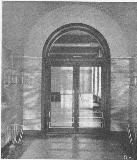
Abb. 9 Vorraum, Blick gegen die Schalterhalle.
