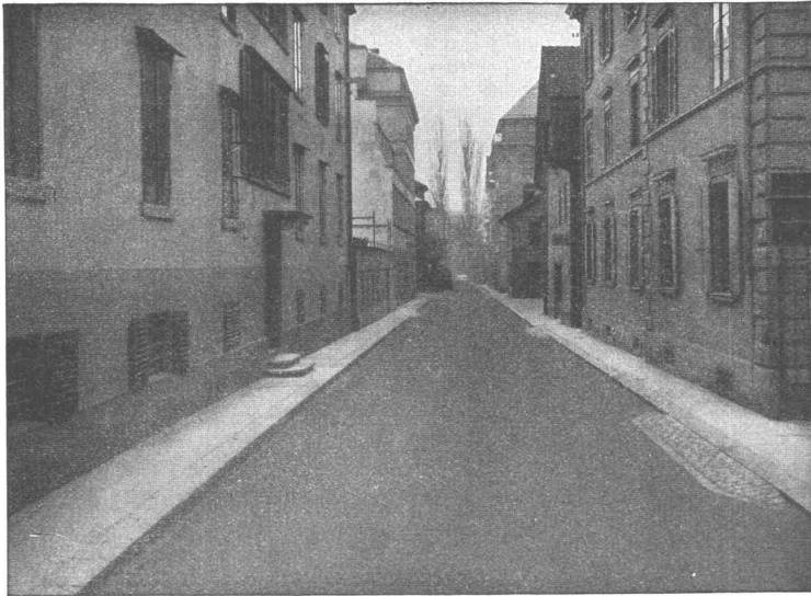
GLARNISCHSTRASSE ZÜRICH Walz-Asphalt: Topeka, 6 cm stark
