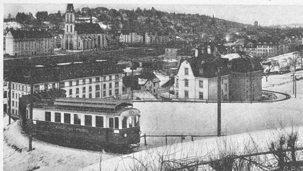
Abb. 1. Zahnstangenrampe von 92‰ Steigung in 30 m-Kurve bei St. Gallen.
