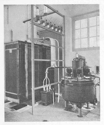
Abb. 14. Unterstation Gais. Gleichrichter mit Haupttransformator und Hilfstransformtor.
