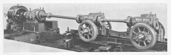
Abb. 7. Untersuchung der Zwischengetriebe auf dem Prüfstand der Schweizer. Lokomotiv- und Maschinenfabrik Winterthur.
