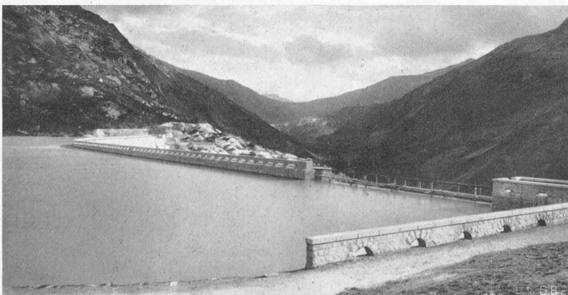
Abb. 7. Stausee Gelmer, im Hintergrund der Nollen, darüber die Grimsel-Passhöhe.
