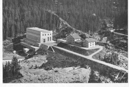
Abb. 10. Maschinensaal Handeck,  $4 \times 30000$  PS.
