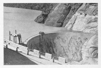
Abb. 6. Luftseite der Spitallammsperre; Stufenhöhe 2 m.
