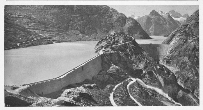
Abb. 2. Gesamtbild aus Nordost über Seeufereggmauer, Nollen, Spitallamm-Mauer und Grimsel-Stausee. Rechts im Hintergrund das Finsteraarhorn.
