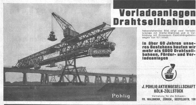
Nebenstehendes Bild zeigt zwei Verlade-brücken mit Greifer-Drehkran und in Ver-bindung mit Grossraum-Elektrohängebahn-wagen von 10 t Inhalt.
