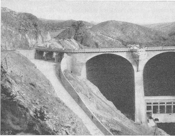
Abb. 1. Rechtsufriger Hochwasserüberlauf der Coolidge-Staumauer (U. S. A.).
