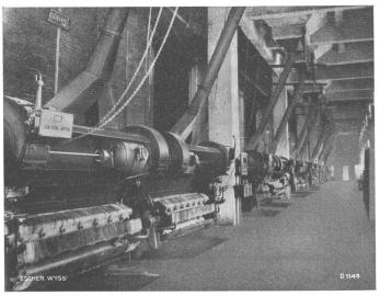
Anlage Shiretori, Japan. — 6 Escher Wyss-Steilrohrkessel mit je 500 m² Heizfjäche. 21 at Betriebsdruck. — Jeder Kessel hat 2 Unterwind-Wanderroste.
