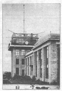
London, Flughafen Croyden Abdichtung des stark dem Wetter ausgesetzten Turmes / Fugendichtung mit SIKA-Zement / Dich-tung der stark porösen Kunststeine mit SIKA-Zementschlemme / Imprägnierung der Flächen mit Conservado
