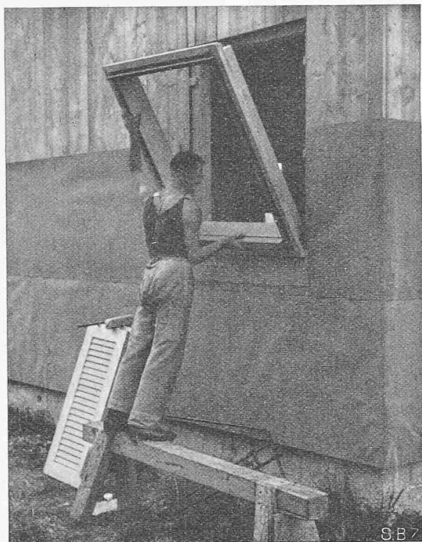
Abb. 12 und 13. Einzelphasen der Montage der fertigen Bauteile im Rohbau.
