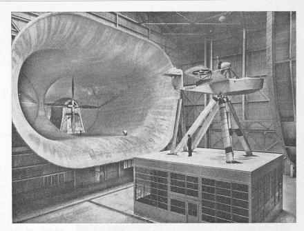
Abb. 1. Versuchsstand in Langley Field, U.S.A., für aerodynamische Untersuchungen in Naturgrösse.
