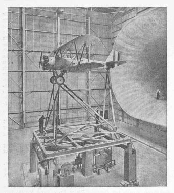
Abb. 2. Versuchsstand Langley-Field, ohne die Verschalung der Messapparate.
