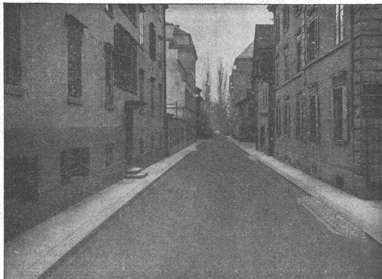
GLARNISCHSTRASSE ZÜRICH Walz-Asphalt: Topeka, 6 cm stark
