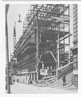
Abb. 5. Niveau der Rue de Genève, Stahlskelett-Montage.
