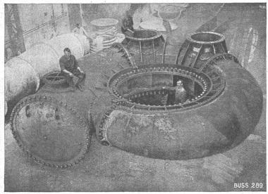
Spiralgehäuse einer Turbine, Durchmesser des Einlaufes 1900 mm, sich reduzierend auf ca. 1000 mm, Betriebsdruck 8 Atm., Prüfdruck 14 Atm. BUSS<sup>a</sup> BASEL
