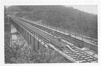
Abb. 3. Draufsicht des neuen, eingeschobenen Vollwandträgers, gegen Osten.
