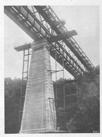
Abb. 2. Neuer Träger eingeschoben, ummantelter alter eiserner Pfeiler.
