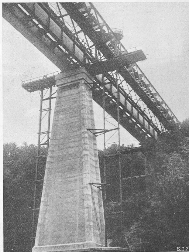
Abb. 2. Neuer Träger eingeschoben, ummantelter alter eiserner Pfeiler.
