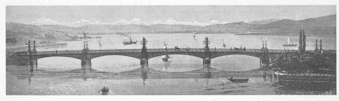
Abb. 1. Konkurrenz-Projekt von 1882 für die Quaibrücke in Zürich. — Verfasser Phil. Holzmann & Cie. (Frankfurt) und Arch. E. Schmid-Kerez, Zürich. Die Ausführung entspricht bis auf unwesentliche Einzelheiten diesem Entwurf. Rechts im Vordergrund verdeckt das Bauschänzli die fünfte Brückenöffnung.
