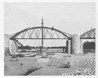
Abb. 18. Eisernes Lehrgerüst aus verschraubten Stabelementen zusammengesetzt, in erstmaliger Verwendung beim Bahnbau Asti-Chivasso (1911/12).
