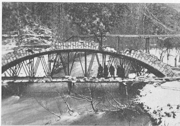
Abb. 20. Das selbe Lehrgerüst wie oben, für die Brücke über die Nera bei Km. 30 der Spoleto-Norcia-Bahn.
