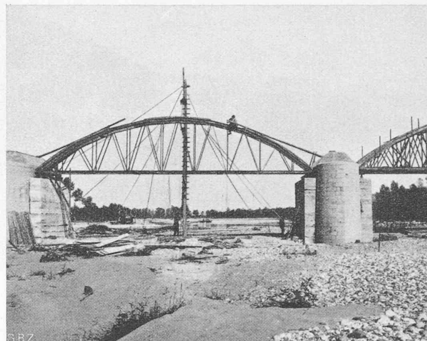
Abb. 18. Eisernes Lehrgerüst aus verschraubten Stabelementen zusammengesetzt, in erstmaliger Verwendung beim Bahnbau Asti-Chivasso (1911/12).
