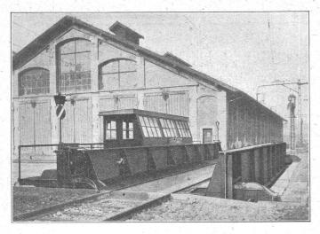
Elektrische Schiebebühne von 150 Tonnen Tragkraft und 18 m Grubenbreite, der Schweiz. Bundesbahnen, Kreis II, Luzern
