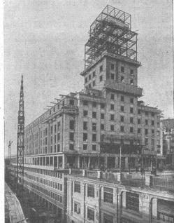
Bel-Air Metropole S. A. Lausanne Geschweisster Stahl-Skelettbau. 2000 t Stahl, 150000 m³ Volumen. Bauzeit 8 Monate.
