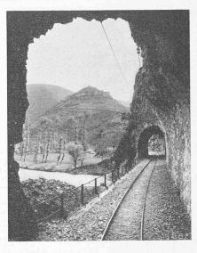
Abb. 15. Halb- und Volltunnels "Le lastre" (Km. 30). Vgl. die Abbildungen 12 u. 13.
