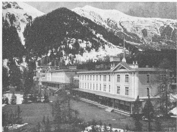
Abb. 16. Gleicher Standpunkt wie Abb. 15, ursprünglicher Zustand: Hauptbau von 1901; ganz im Hintergrund die Erweiterungsbauten von 1905 und 1909.
