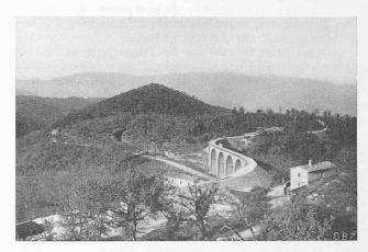
Abb. 3. Blick aus Südost auf den S-förmigen Viadukt von Caprareccia (acht Oeffnungen zu je 12 m Lichtweite). Km. 7,8.
