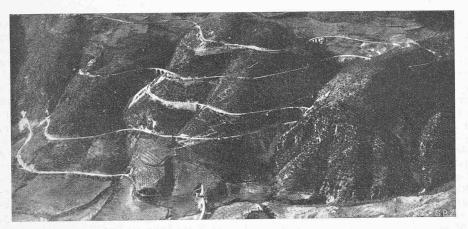
Abb. 7. Künstliche Entwicklung für den Abstieg ins Neratal (Km. 10,8 bis Km. 19,1) Fliegerbild aus NO. Länge der Entwicklung 8,4 km, Höhenunterschied 326 m.
