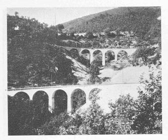
Abb. 5. Viadukte von Torre (Km. 12,3 und 13,1), je 5 Oeffnungen zu 10 m; bei der obersten Kehre der künstlichen Entwicklung für den Abstieg ins Neratal.
