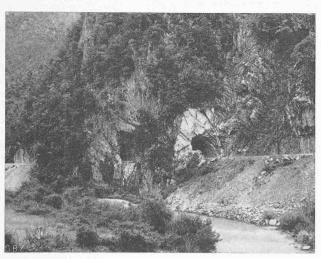
Abb. 11. Durchstich einer Felswand in zwei kurzen Tunneln bei Km. 26,3 der meterspurigen Spoleto-Norcia-Bahn.
