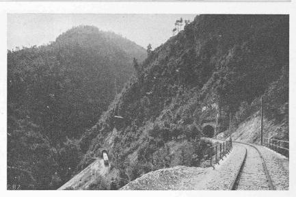
Abb. 6. Hufeisenförmiger Kehrtunnel "Vallegiana", 450 m lang (Km. 16,4 bis Km. 16,9). Unterste Kehre der künstlichen Entwicklung zum Abstieg ins Neratal, aus N O.
