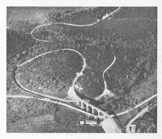
Abb. 2. Künstliche Entwicklung in offener Schleife bei Caprareccia, aus SO. Im Vordergrund (von links nach rechts) überbrückte Strasse.
