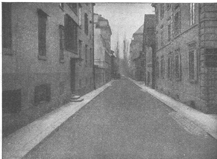
GLARNISCHSTRASSE ZÜRICH Walz-Asphalt: Topeka, 6 cm stark
