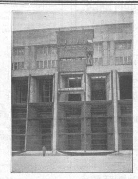
Energie Electrique du Rhin. Kraftwerk Kembs. Rechenreinigungsmaschine.
