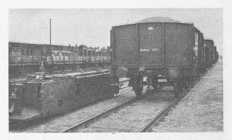
Abb. 10. Schlepper auf dem Rangierbahnhof Magdeburg-Rothensee beim Zusammendrücken von Wagen in den Richtungsgeleisen.
