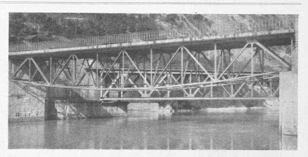
Abb. 1. Die neue geschweisste Strassenbrücke bei Leuk. (Im Hintergrund die Eisenbahnbrücke.)
