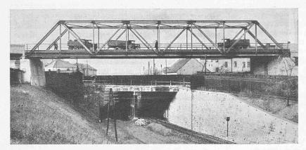
Abb. 4. Ansicht der 49,2 m weit gespannten, völlig geschweissten Strassenbrücke in Pilsen.
