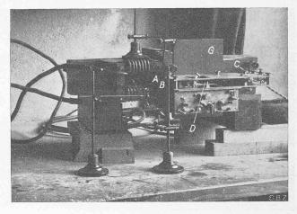
Abb. 5. Schütteltisch mit darauf befestigtem Spannungsmesser,
