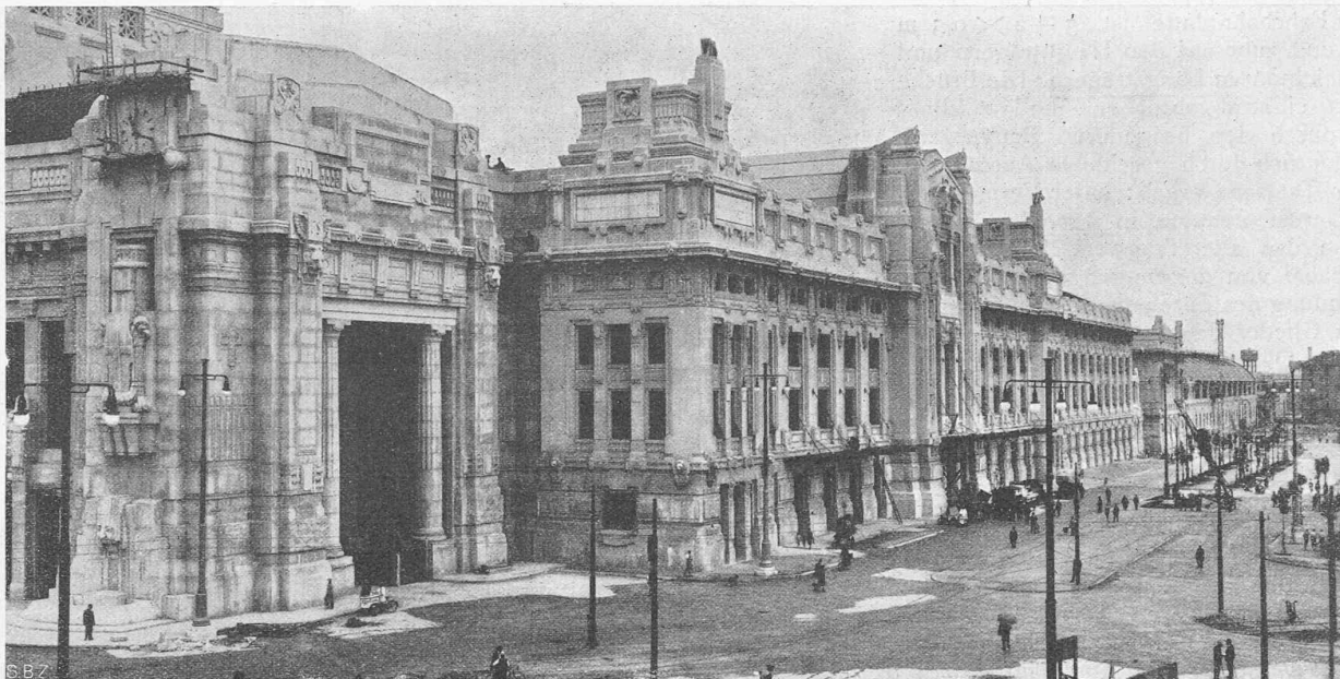
Abb. 13. Oestliche Einfahrt zur Zufahrhalle, und östliche Seitenfront an der Via Aporti. — Arch. Prof. Ulisse Stacchini, Mailand.
