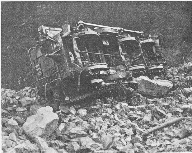
Abb. 1. Das obere Triebgestell der am 3. August 1931 abgestürzten elektrischen Lokomotive Nr. 411 der Rhätischen Bahn.
