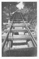
Abb. 2. Gerüst zum Heraufziehen des Gepäckwagens und obern Triebgestells.
