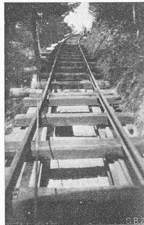
Abb. 2. Gerüst zum Herausziehen des Gepäckwagens und obren Triebgestells.
