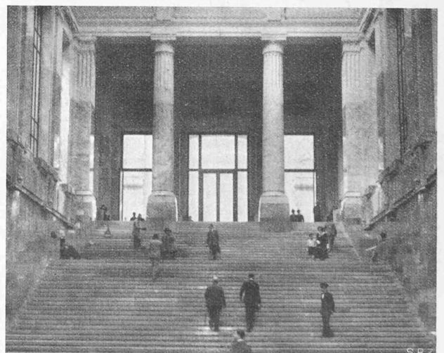
Abb. 11. Aufgangstreppe zur „Galleria di testa“.
