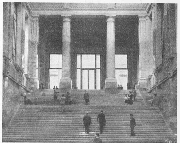
Abb. 11. Aufgangstreppe zur „Galleria di testa“.
