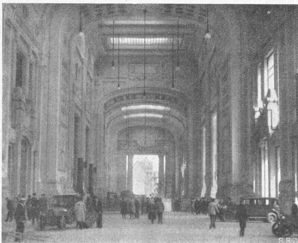
Abb. 10. Vorfahrhalle, „Galleria delle carrozze“.
