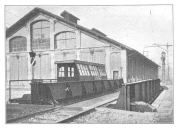
Elektrische Schiebebühne von 150 Tonnen Tragkraft und 13 m Grubenbreite, der Schweiz. Bundesbahnen, Kreis II, Luzern
