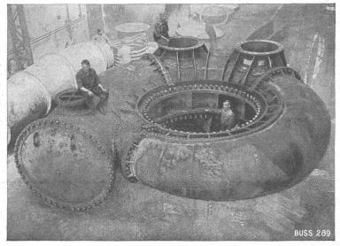
Spiralgehäuse einer Turbine, Durchmesser des Einlaufes 1900mm, sich reduzierend auf ca. 1000mm, Betriebsdruck 8 Atm., Prüfdruck 14 Atm. BUSS<sup>®</sup> BASEL
