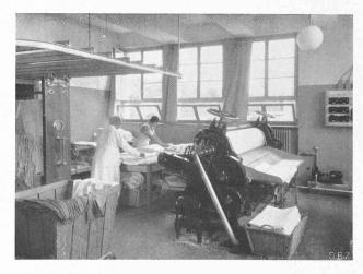
Abb. 29. Heissluft-Tröckneapparat, Dampf-Glättemaschine.
