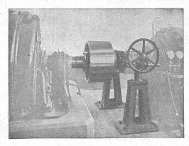
Benn-Kupplung zur Ueberträgung von 3000 PS bei 1000 Umdrehungen in der Minute in einer Akkumulieranlage.
