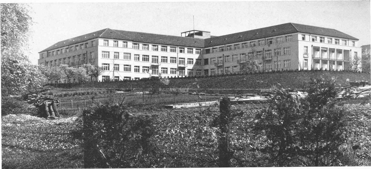
Abb. 5. Gesamtansicht der Bettenflügel aus Süden. (Photographische Aufnahmen von J. Meiner & Sohn, Zürich.)
