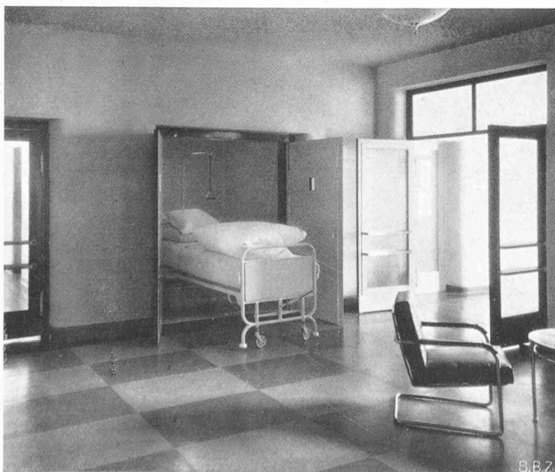
Abb. 10. Interne Verkehrshalle mit Bettenaufzug.
