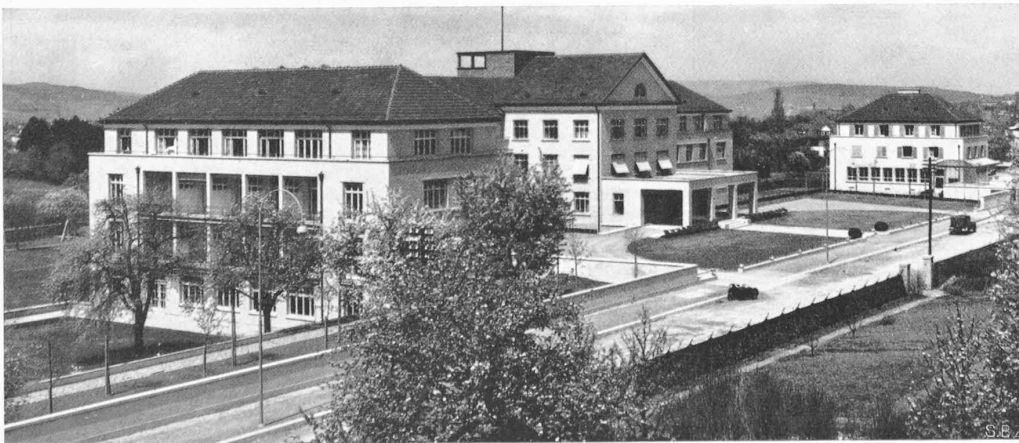
Abb. 3. Gesamtbild der „Privatklinik Hirslanden“ in Zürich, aus Osten, von der Anfahrtseite; rechts das Dienstgebäude.
