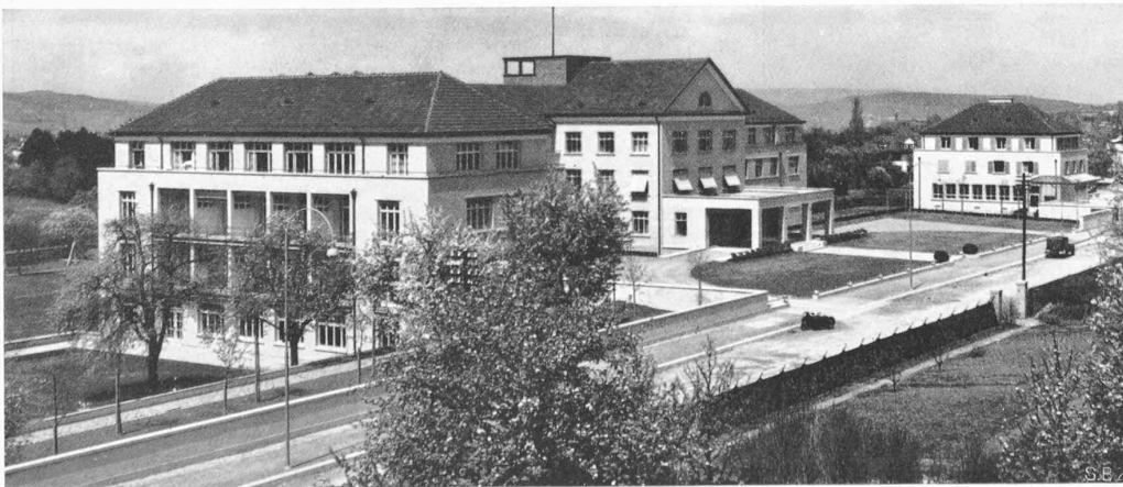
Abb. 3. Gesamtbild der „Privatklinik Hirslanden“ in Zürich, aus Osten, von der Anfahrtseite; rechts das Dienstgebäude.
