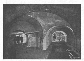
Stollenbau - System Bauschäfer - ausgeführt für die Zementwerke A.- G.
