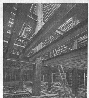
Tresorkonstruktion eines Bankgebäudes
