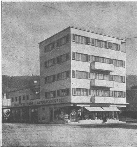
Geschäftshaus in Zug mit Bitumitekt eingedeckt
