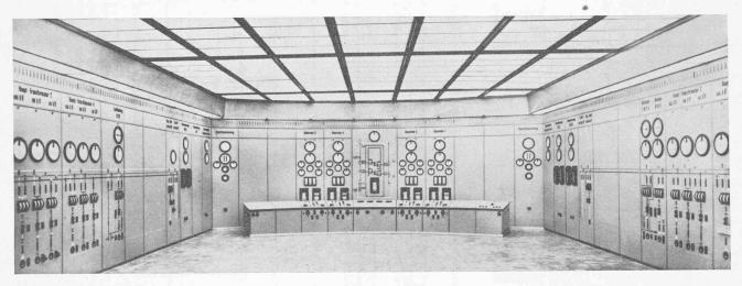
Abb. 46. Kommandoraum. Blick gegen das Generatoren-Pult. Links und rechts Transformatoren- und Freileitungs-Felder.
