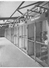
Abb. 49. Sammelschienenraum 10,5 kV der Eigenbedarfs-Anlage.
