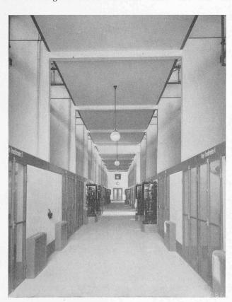
Abb. 47. Bedienungsgang der 10,5 kV-Hauptschaltanlage.
