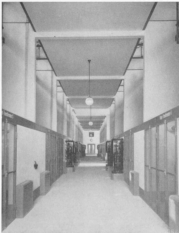
Abb. 47. Bedienungsgang der 10,5 kV-Hauptschaltanlage.
