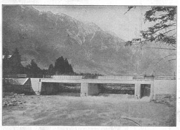
Zwei automatische Segmentschützen in der Alfenz, je  $12,50 \times 2$  m.
