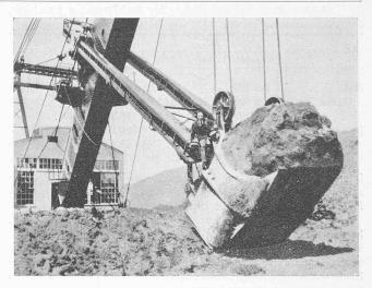
Abb. 2. 12 m3-Löffel des gleichen Baggers.
