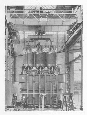
Abb. 44. Oerlikon-Transformator beim Einsetzen in den Kessel.
