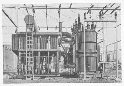
Abb. 43. Vierwicklungs-Transformator der Maschinenfabrik Oerlikon für 32 500 kVA mit seiner Kühlergruppe.
