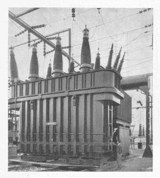
Abb. 41. Vierwicklungs-Transformator von BBC für 32500 kVA.
