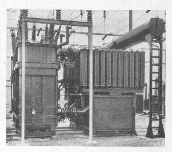
Abb. 42. Transformator von BBC mit seiner Kühlergruppe.
