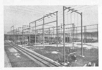
Abb. 36. Eiserne Hochgerüste der Freiluft-Anlage.
