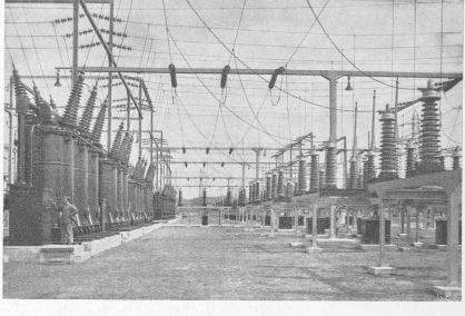
Abb.'37. Spannungs- u. Stromwandler, rechts Oelschalter.
