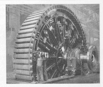
Abb. 32. Polrad eines Generators in der Werkstatt.
