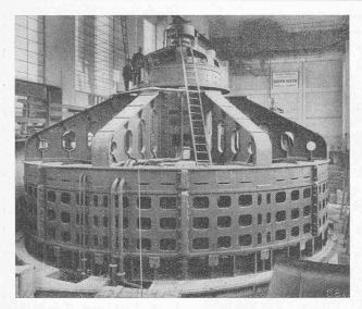
Abb. 31. Zusammenbau eines Generators im Kraftwerk.
